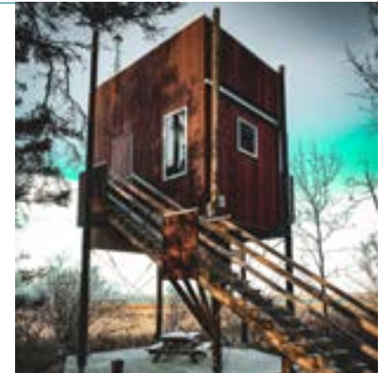
Chalet perché - Parc côtier Kiskotuk
